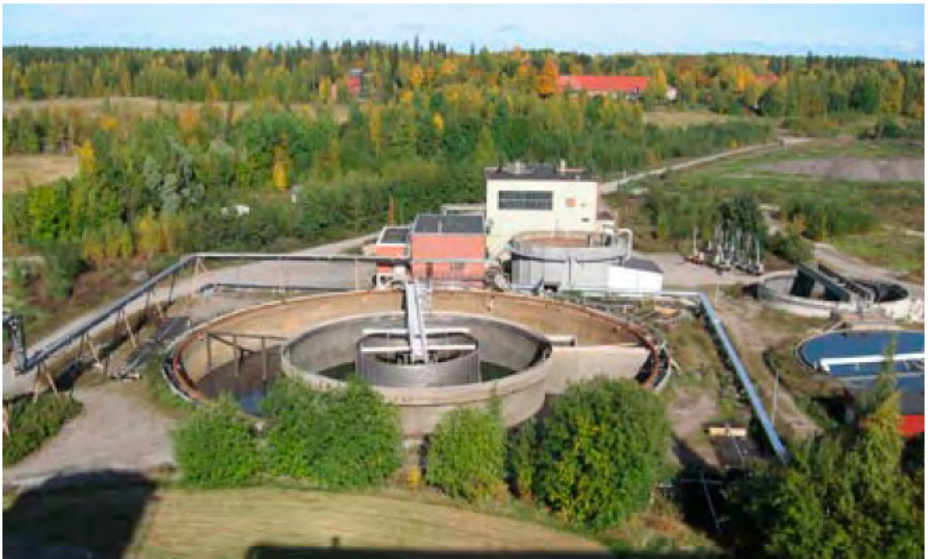
Jätteenkäsittelyä varten rakennettiin 1970-luvun aikana tehtaan koillispuolisen lietealtaan (entinen järvenlahti) länsipäähän liettämö puhdistusaltainen sekä jätteenpolttolaitos. 2000-luvun alussa alueelle on lisätty kaksi mikroflotaatiolaitesuoja. Kuva M Real.
