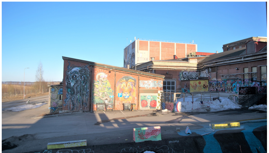
Kuvassa Märkämassavarasto ja sen oikealla puolella näkyvä Kuivaamo. Takana korkeampana nousee Hiertämön rakennus. Etualalla oleva asfaltoitu alue on osa tulevaa Kuivaamonaukiota.
