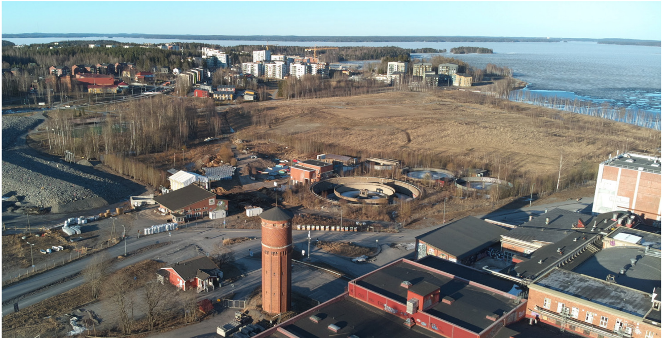
Vesitornin pohjoispuoleiset tehtaan toimintaan liittyneet rakenteet puretaan/on purettu kahta pienempää allasta lukuun ottamatta. @Tampereen kaupunki
